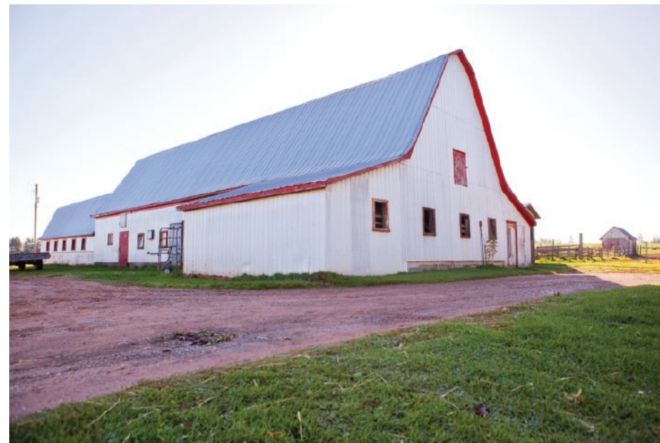
01 Étable d'origine, construite en 1850
